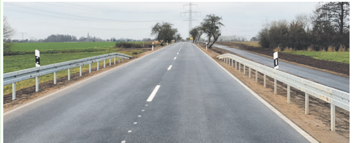
Die neue Fahrbahn der K27 mit neuem Radweg.
