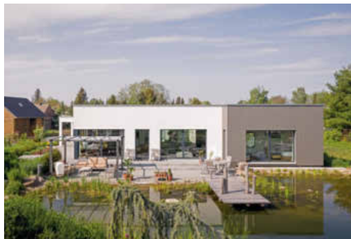
Die Fassade des freigeplanten Bungalows mit Gartenteich von Familie Ulrich ist teilweise mit Holz verkleidet, um das Haus der ländlichen Umgebung anzupassen. Foto: djd/WeberHaus
