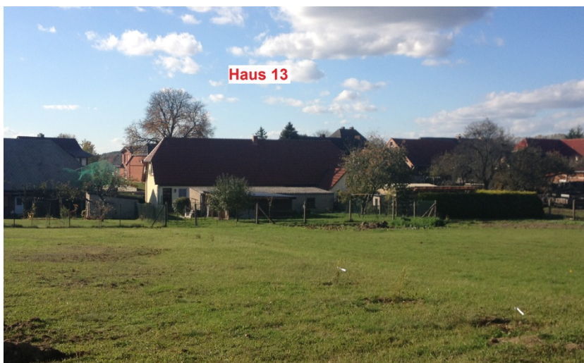
Abbildung 19: Bebauung 13 (Wohnhaus), Ansicht Ost
