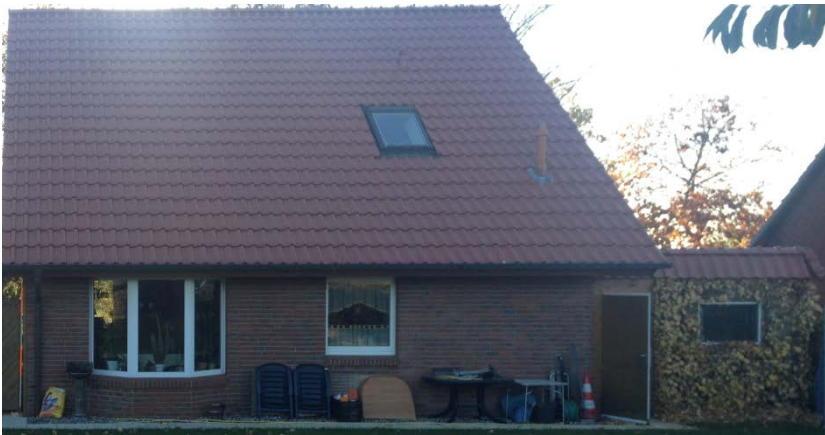
Abbildung 21: Bebauung 20 (Wohnhaus), Ansicht Nordost
