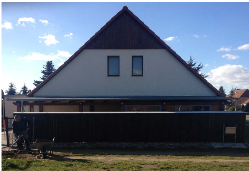
Abbildung 16: Bebauung 10 (Wohnhaus), Ansicht Ost
